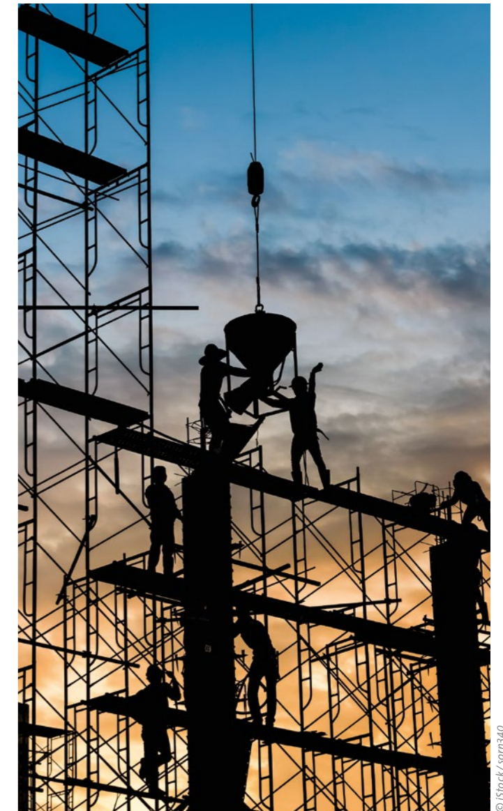
Ein Zeiterfassungsterminal ist aufgrund der Größe vieler Baustellen problematisch.
