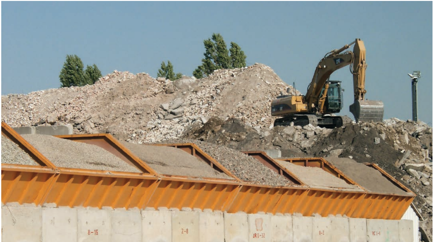
Nach der Aufbereitung stehen die Recycling-Baustoffe wieder für den Einbau bereit.
